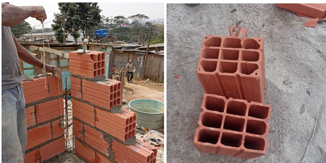
Figura 9. Pedreiro subindo as fiadas de alvenaria em forma de meia pirâmide e checando prumo da parede (fonte: acervo dos autores, São Paulo, 2022).
