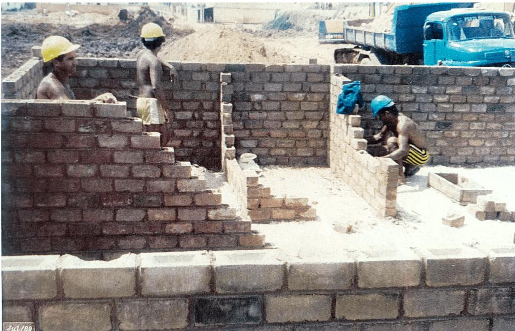
**Figura 10.** Foto antiga de mutirantes construindo casas com tijolos de solo-cimento. (fonte: Acervo de moradora.)
