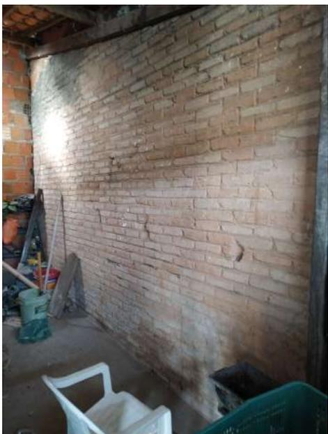
**Figura 11.** Foto de parede de tijolos de solo-cimento original de uma das casas do mutirão 50. Dezembro/2020. (fonte: Acervo do autor.)
