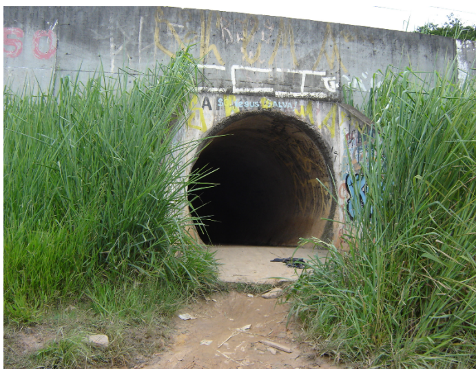
Figura 8: entrada do túnel de passagem sob linha férrea antes de sua recuperação (fonte: GONÇALVES, s/d)
