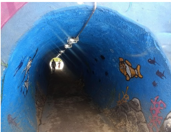
Figura 9: entrada do túnel de passagem sob linha férrea pós recuperação (fonte: Thais Regina Boppre Melara, 3/07/2019)
