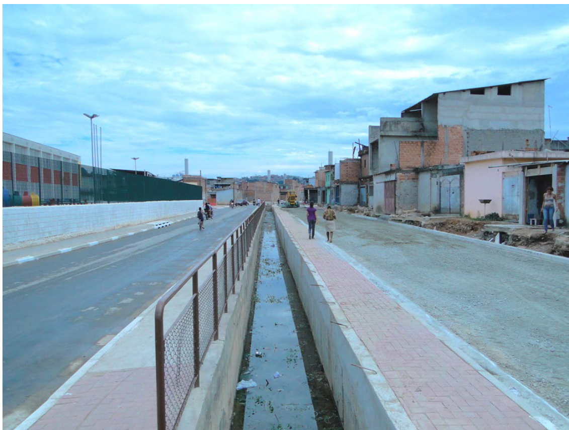
Figura 4: córrego canalizado e ruas pavimentadas pós urbanização (fonte: GONÇALVES, s/d)
