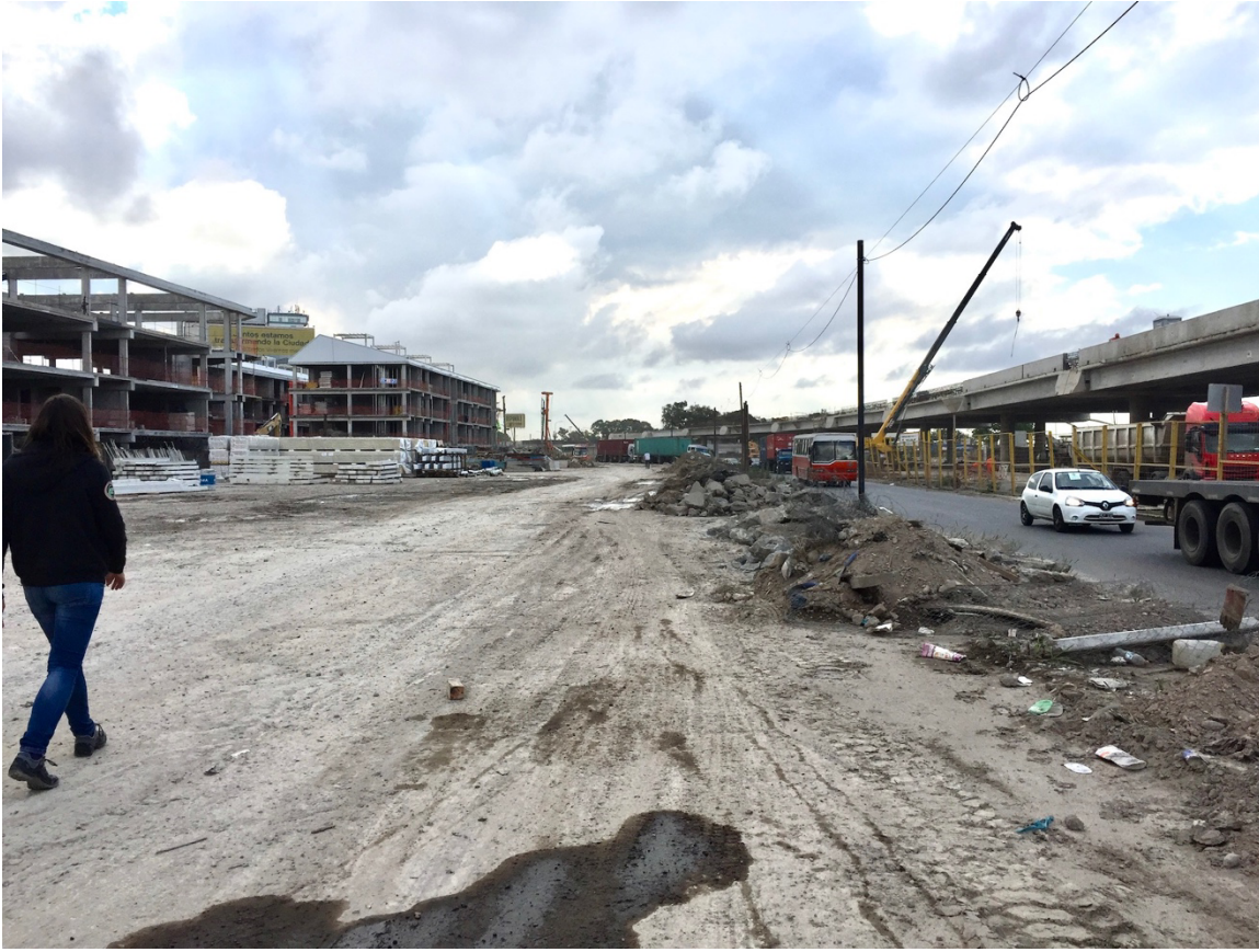
Imagen 7: Paseo del bajo (derecha) y conjunto de viviendas nuevas del sector YPF (izquierda) en construcción, año 2018. (Fuente: Elaborado por las autoras.)
