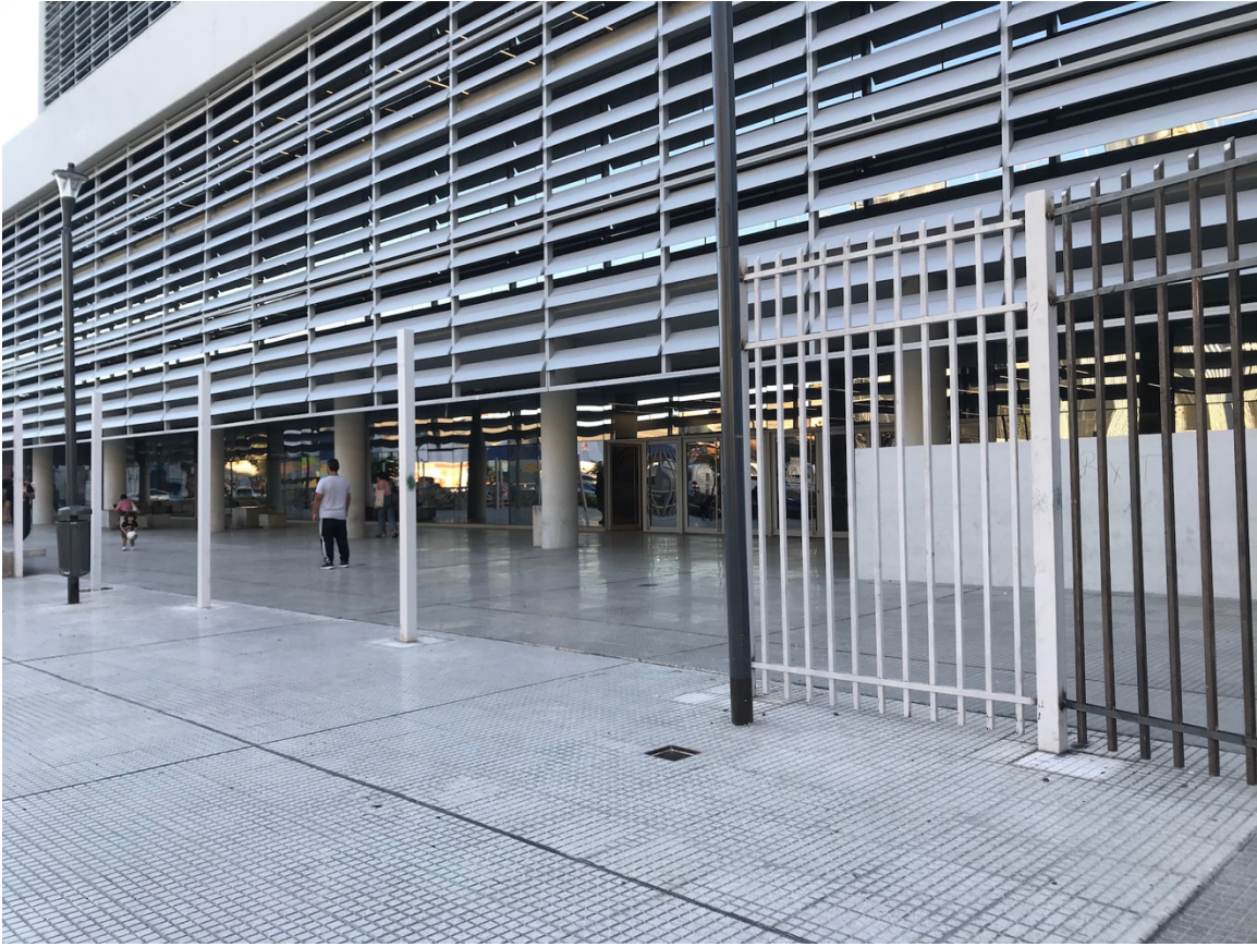
Imagen 4: Instalación de rejas frente al edificio del Ministerio de Educación de la Ciudad en el Barrio Mugica. (Fuente: Elaborado por las autoras.)
