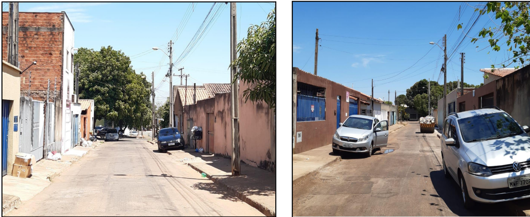
Figuras 6 e 7 – Falta de acessibilidade na ARNO 32
