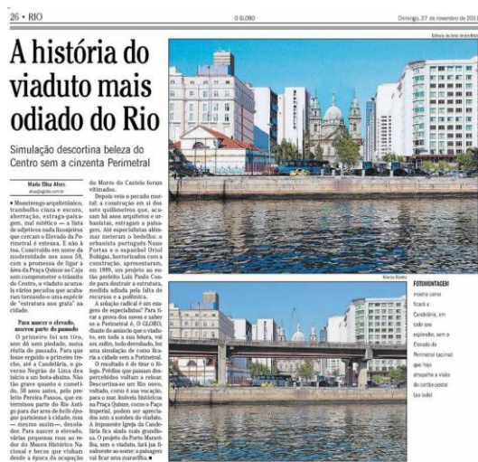
Figura 1. O aspecto de degradação do porto foi atribuído, em parte, ao elevado da Perimetral. (Fonte: Jornal O Globo, 2011).
