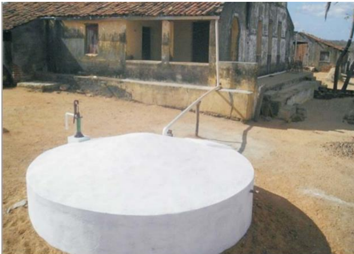
Figura 1 – Cisternas de placas com sistema de captação de água
