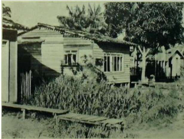
Figuras 15 e 16: Acima, Ocupação espontânea em área de baixada no bairro da Matinha (hoje chamado bairro de Fátima) no final da década de 1960. E, abaixo, Ocupação espontânea em área de baixada no bairro da Terra Firme final da década de 1960. Fonte: Penteadó (1968, p. 341 e 335).
