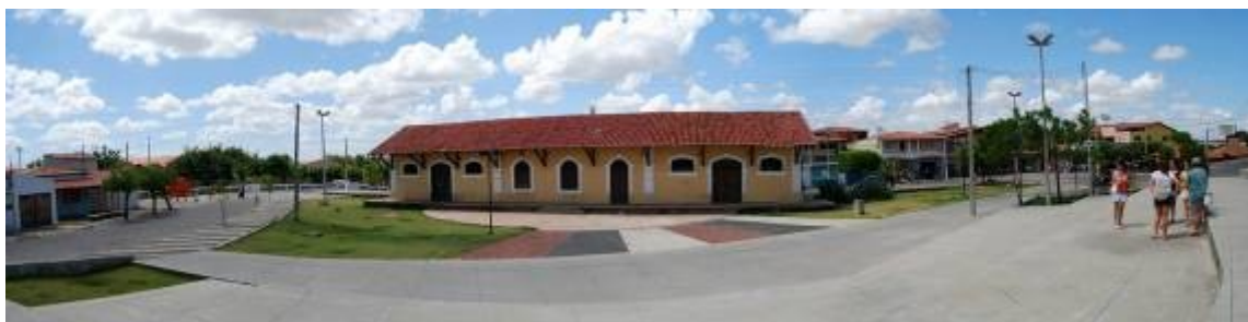
Figura 12 – Urbanização das imediações da Antiga Estação Ferroviária de Quixeramobim. Ano: 2010. Fonte: Arquivo Pedro Esdras.
