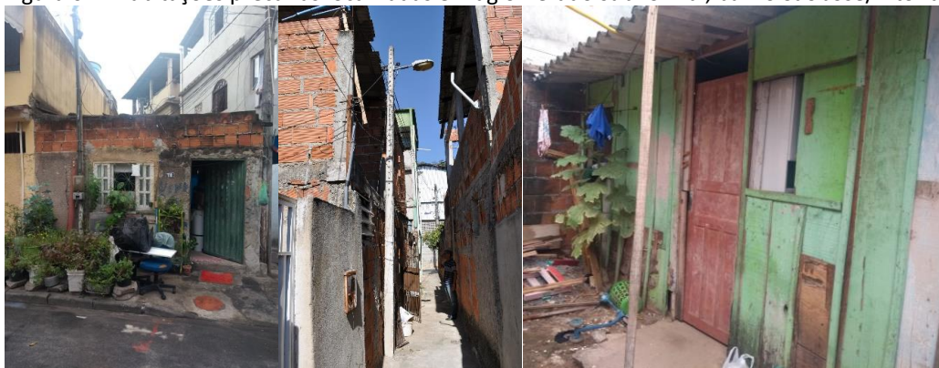
Figura 01 - Habitações precárias localizadas em aglomerado subnormal, bairro São José/Vitória.
