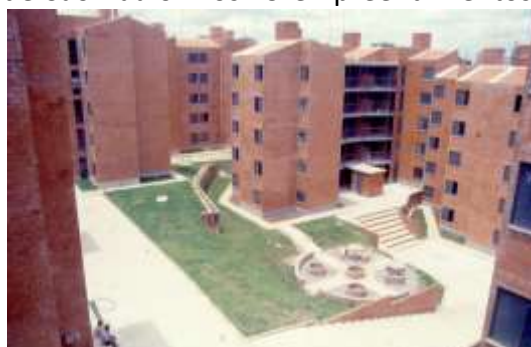
Imagem 1 – Empreendimento COPROMO localizado no município de Osasco. Programa de mutirão do governo estadual. Assessoria técnica Usina. Fonte: acervo Usina.
