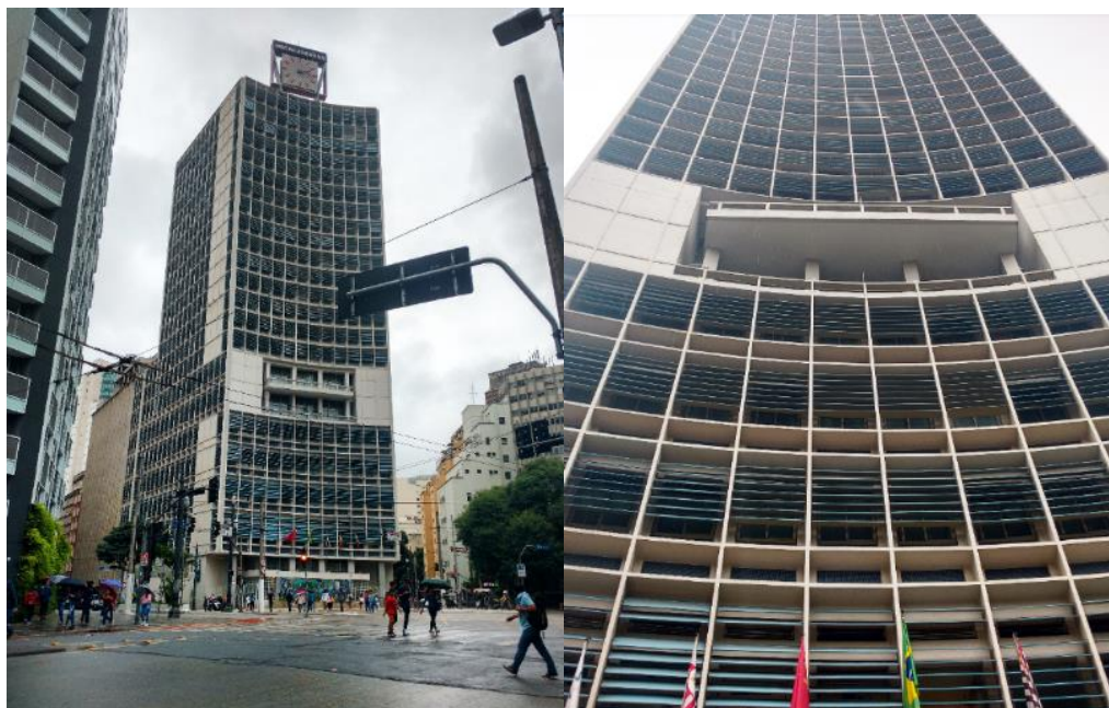
Figura 1.4 - Hotel Jaraguá vista da Rua Coronel Xavier de Toledo (imagem à esquerda) e, fachada principal do Hotel Jaraguá com seus brises (imagem à direita). Fonte: Acervo Pessoal, 2017.
