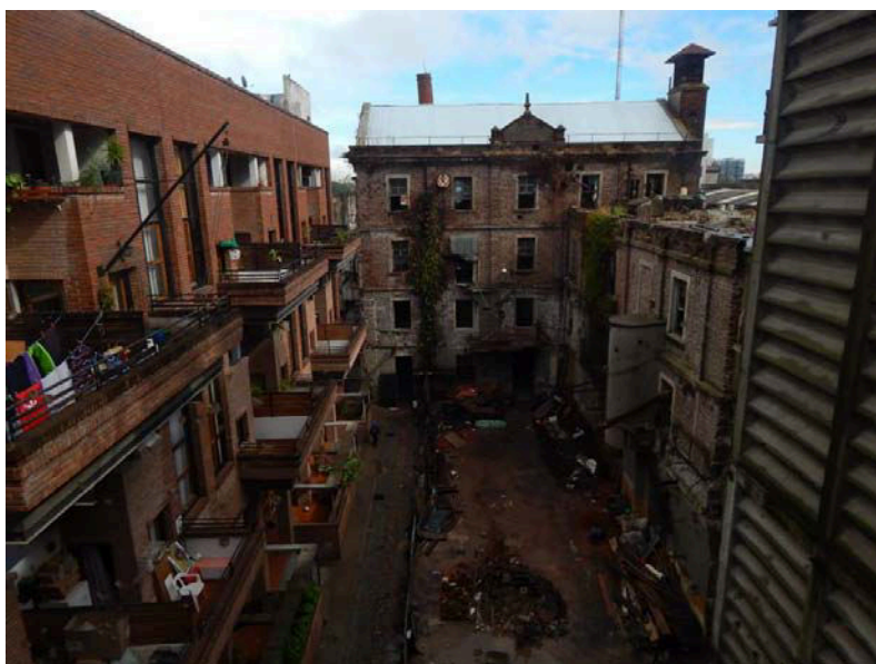
Imagem 2: Cooperativa El Molino e suas preexistências. Fonte: http://moi.org.ar/proyecto-uno/
