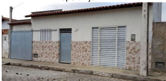
Figura 05: Reforma no Residencial Esperança
