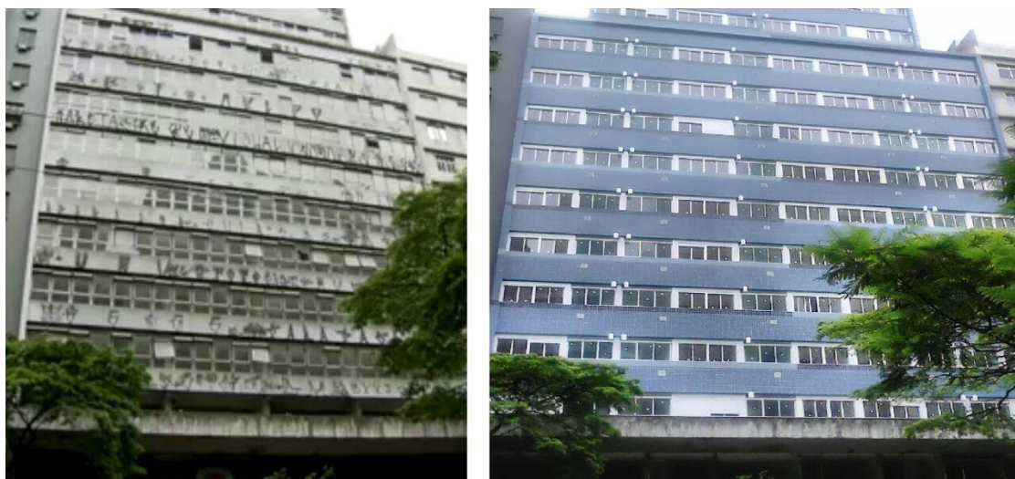
Figura 1 - Fachada do Ed. Dandara antes e após a reabilitação
