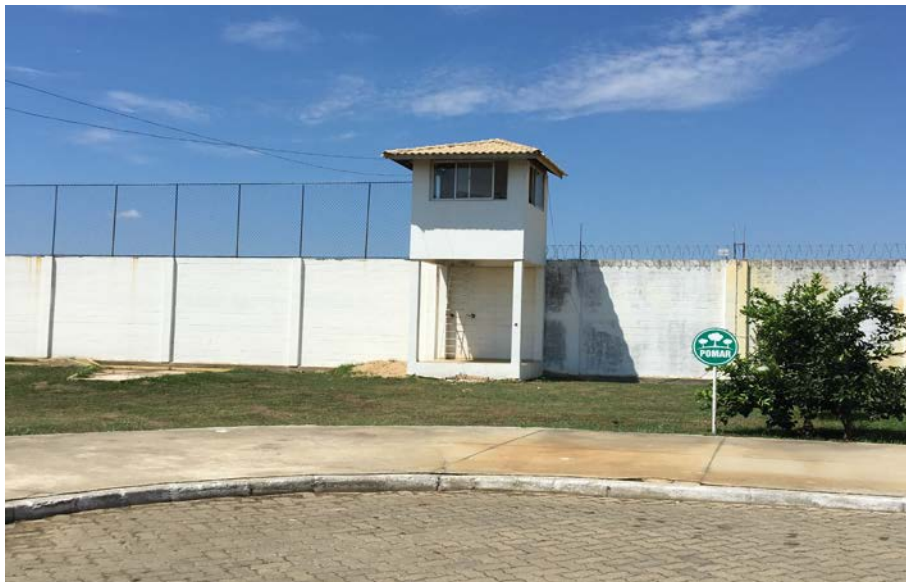
Foto 03: Foto dos Altos Muros e Guarita no entorno - Condomínio Residencial Athenas Park.
