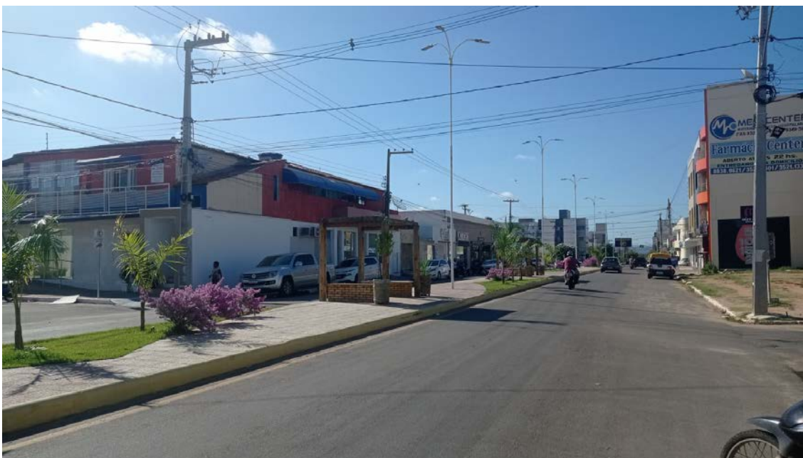
Figura 4. Infraestrutura urbana no Centro de Sousa/PB. (fonte: elaborada pelos autores).
