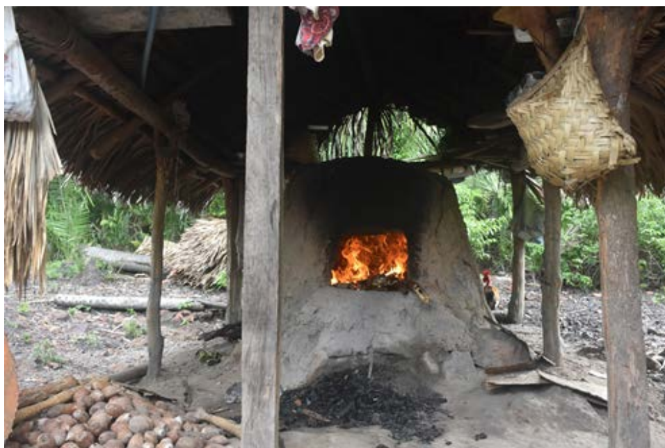
Figura 5. Casa de forno feita em taípe de mão em alpendre nos fundos de moradia. Comunidade Criolis/Boca da Mata, Território Saco das Almas, Brejo/Buriti-MA. (Fonte: Latese, 2021)
