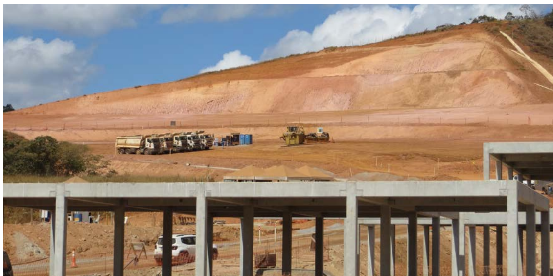
Figura 3. Intervenções de terraplanagem no reassentamento de Paracatu de Baixo, em ago. 2021 (fonte: elaborada pela autora).
