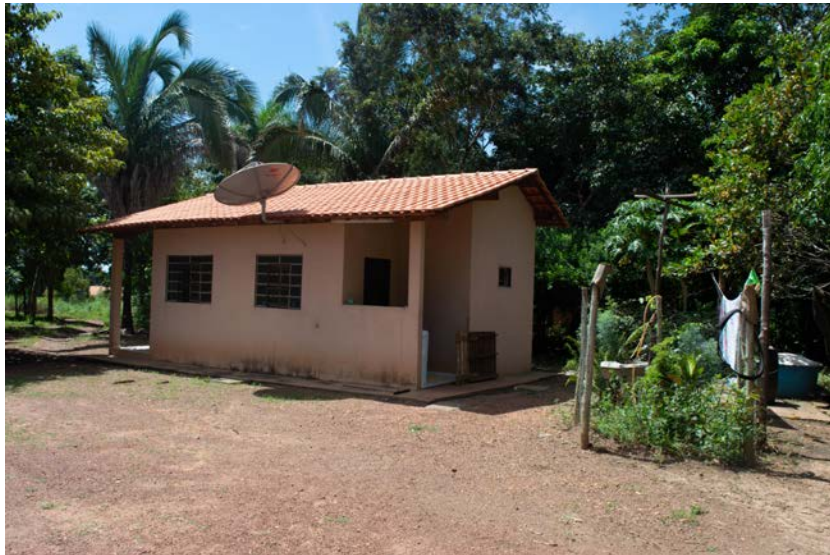
Figura 7 Casa construída pelo PNHR no terreiro de Justina. (fonte:elaborado pela autora)
