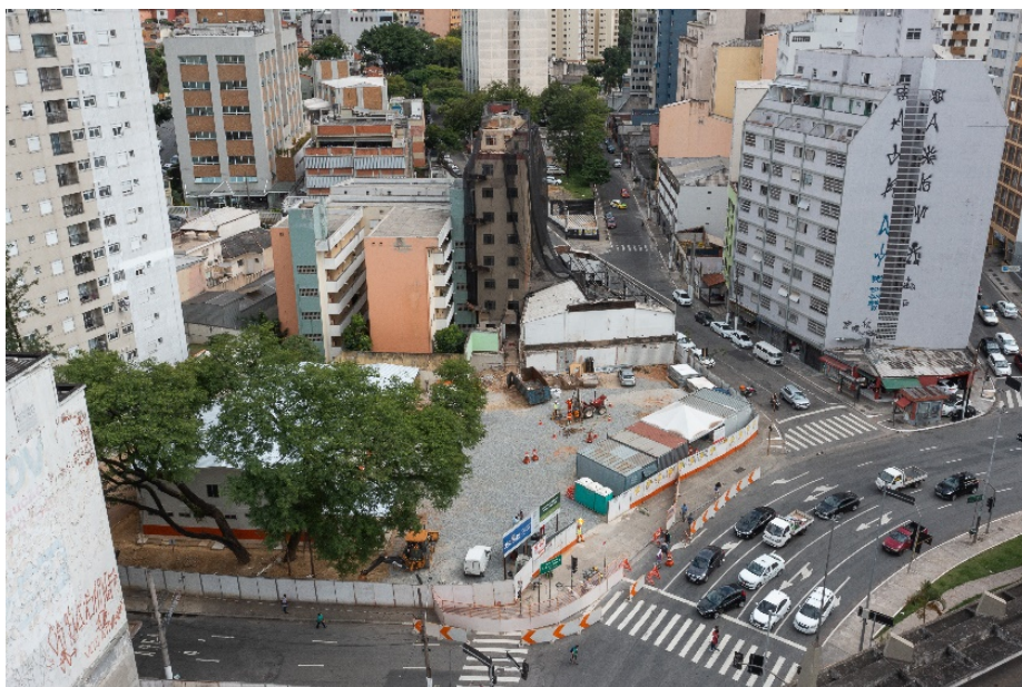
Figura 16: Canteiro de obras da estação 14-bis da linha 6-laranja do metrô. Autor: Linha UNI, 2022.
