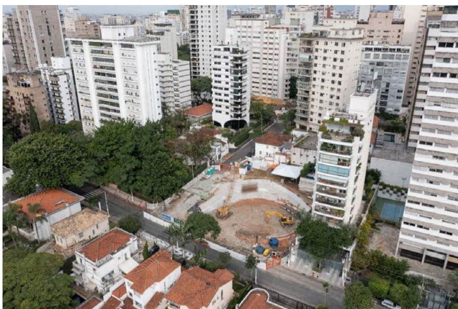
Figura 17: Obras da estação PUC-Cardoso de Almeida do metrô. Autor: Linha UNI, 2022.
