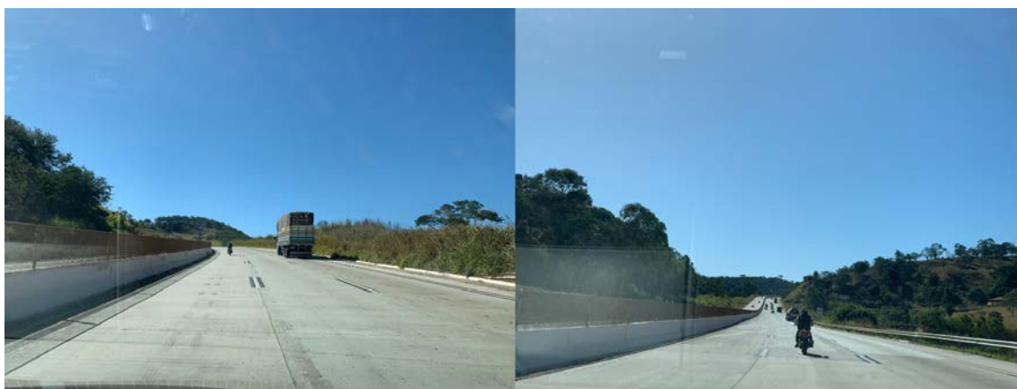
Figura 5 - Duplicação da rodovia BR-381 na altura do município de Nova União, 2022
