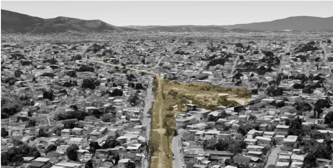
Figura 2. Município de São João de Meriti seccionado pelo antigo ramal ferroviário da Linha Auxiliar e seus espaços residuais. (fonte: Google Maps com destaque feito pelos autores através do software Photoshop , 2022).
