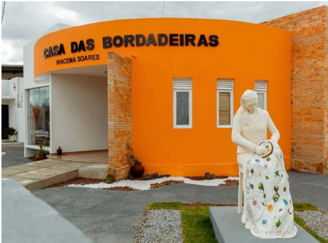
Figura 4. Registro da fachada da Casa das Bordadeiras (Fonte: Saiba Mais, 2022).
