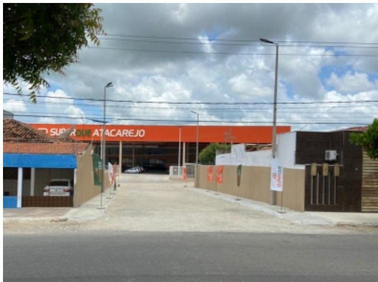
Figura 07: Via de acesso criada após demolição da edificação apresentada anteriormente
