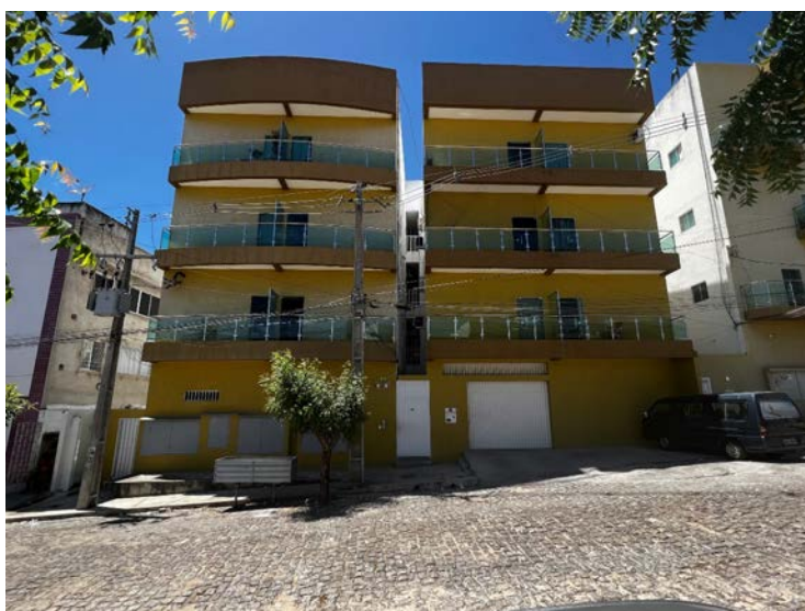
Figura 04: Edificações com 4 andares e recuo de 1 metro entre elas – Pau dos Ferros/RN
