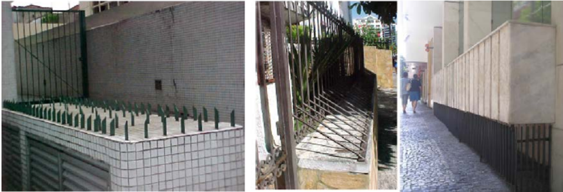
Figura 14. À esquerda espetos sobre caixa de luz, em São Paulo, no centro hastes sobre mureta de edifício residencial, em Salvador, à direita gradil sob jardineira, em Niterói (RJ), todos para evitar que sem-teto ocupam para dormir (fonte: Acervo do grupo da pesquisa, 2004, 2001 e 2007).
