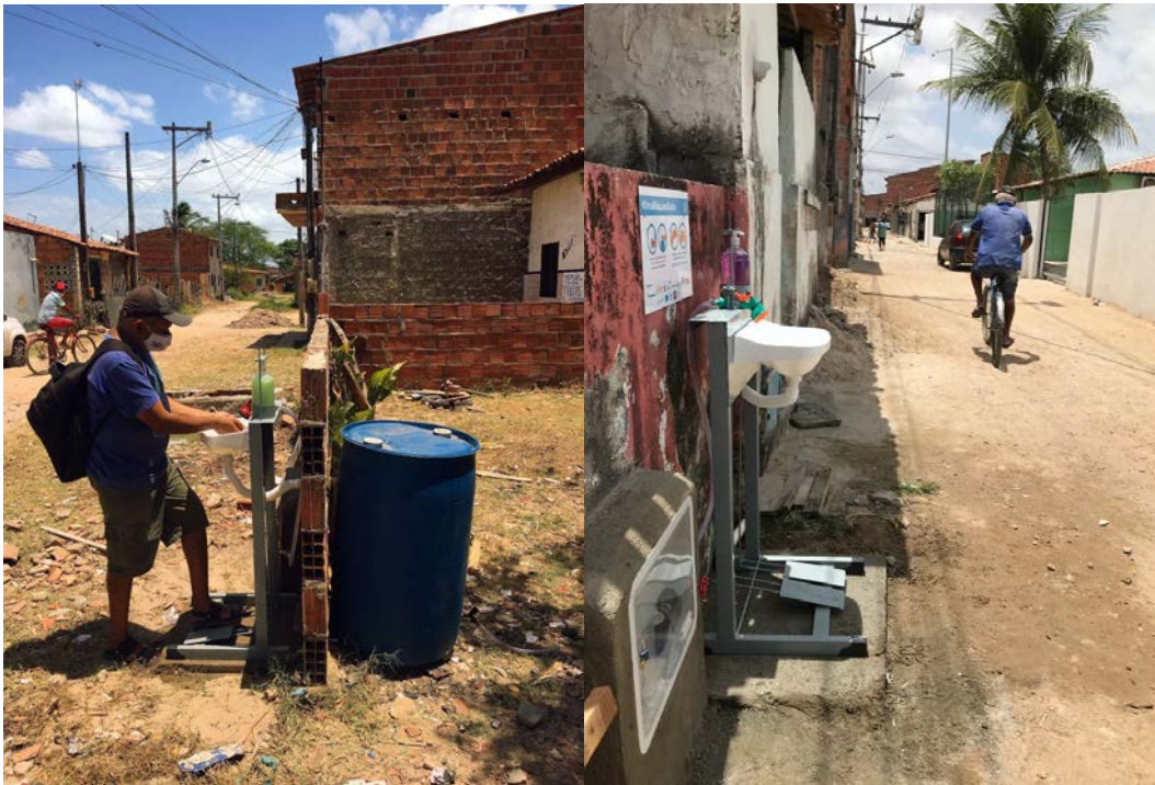
Figura 6. Ponto de higienização instalado no Bom Jardim, na associação dos catadores, mostrando as ruas sem pavimento e o esgotamento através de bombona. (fonte: elaborada pelos autores).
