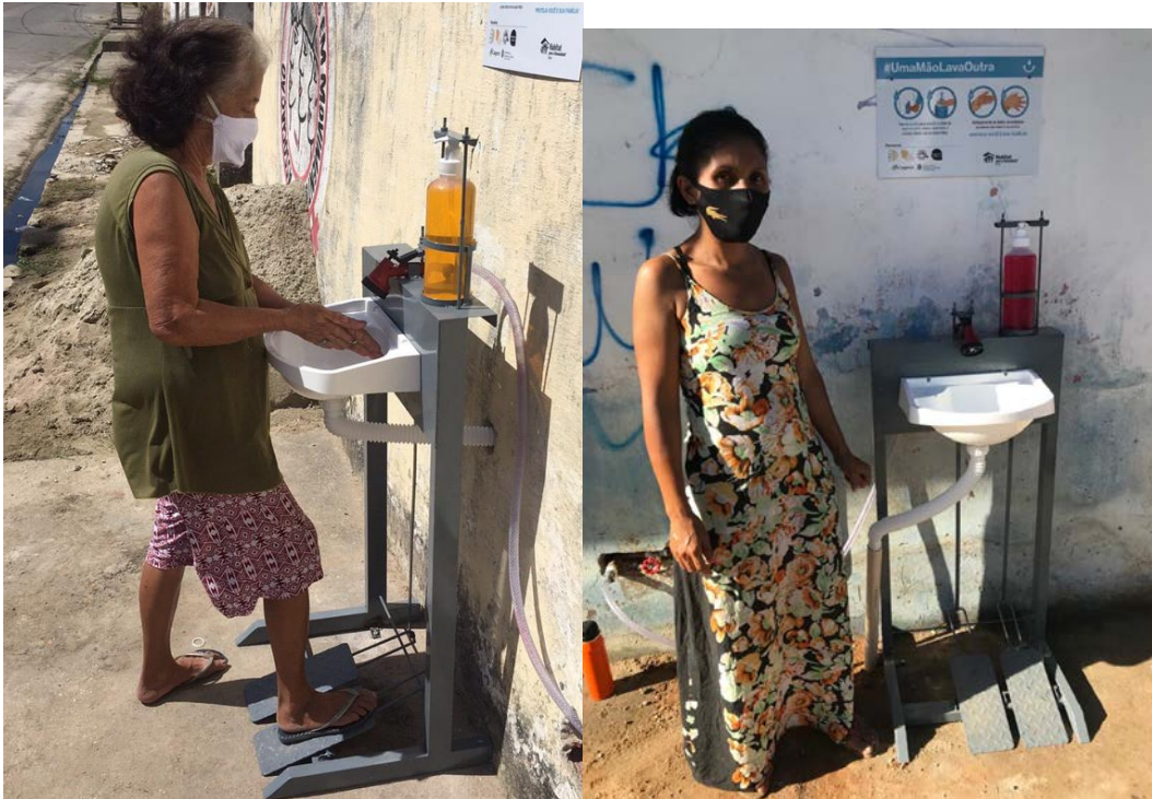
Figura 2. Ponto de higienização instalado no bairro Conjunto Palmeiras com a saída de esgoto ligada à uma bombona dentro da Associação de Mulheres. (fonte: elaborada pelos autores).
