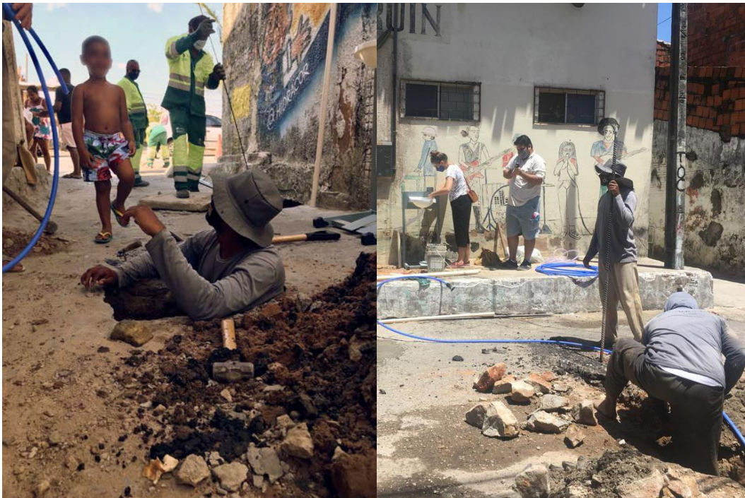
Figura 4. Funcionário da CAGECE procurando rede de esgoto no Lagamar. (fonte: elaborada pelos autores).
