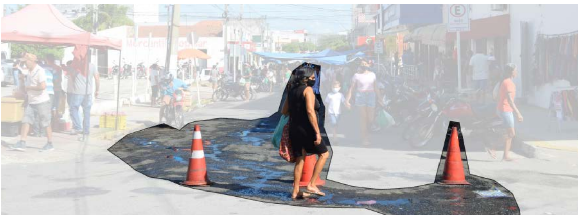
Figura 8. Falta de drenagem superficial da Rua Bevenuto Fialho (fonte: GPUR, 2022, modificado pelos autores).
