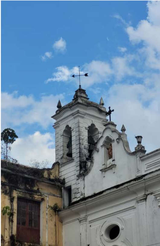
Figura 6. Detalhe torre do sino da capela de São Francisco (fonte: elaborado pelos autores).
