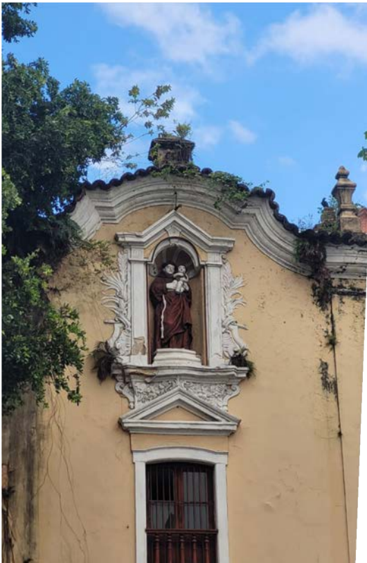
Figura 7. Fachada posterior do Colégio Santo Antônio (fonte: elaborado pelos autores).
