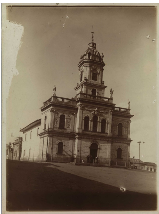
Figura 4. Fotografia com vista para a Igreja Matriz e o Largo 13 de Maio, em data próxima a 1912 (fonte: Matriz ..., 2022).
