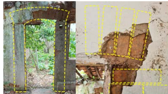
Figura 18: Projeção de sistema estrutural em arco abatido por modulação em tijolo cerâmico maciço.
