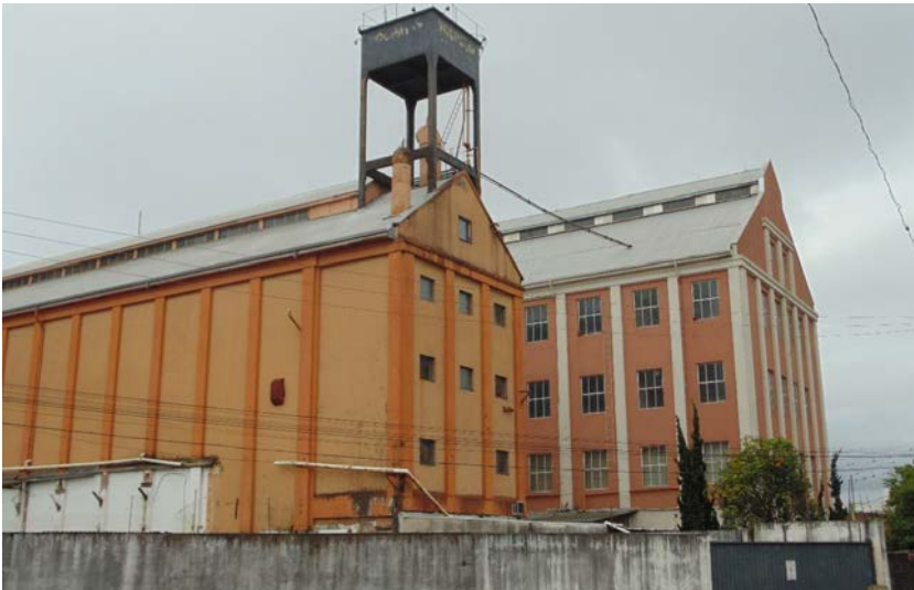
Figura 3. Silo e Moinho do complexo da S. a Moínhos Rio-Grandense (fonte: Milena Albrecht Silveira).
