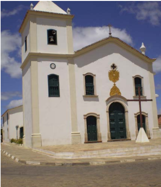
Figura 1 – Igreja do Santíssimo Sacramento de Rio de Contas (foto cedida pelo IPHAN-BA, Escritório Técnico de Lençóis).
