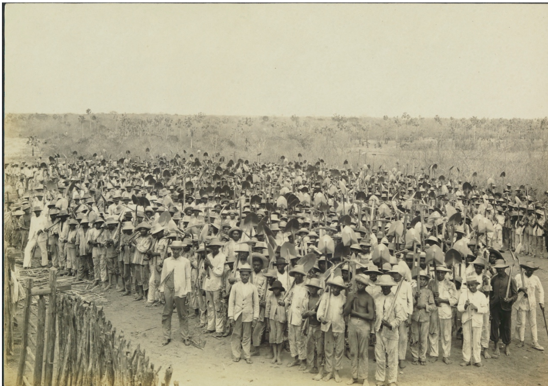
Figura 1. Trabalhadores na construção da estrada de ferro pertencente a Rede de Viação Cearense, fevereiro 1920. (Fonte: Biblioteca Nacional/Brasiliiana Fotográfica)
