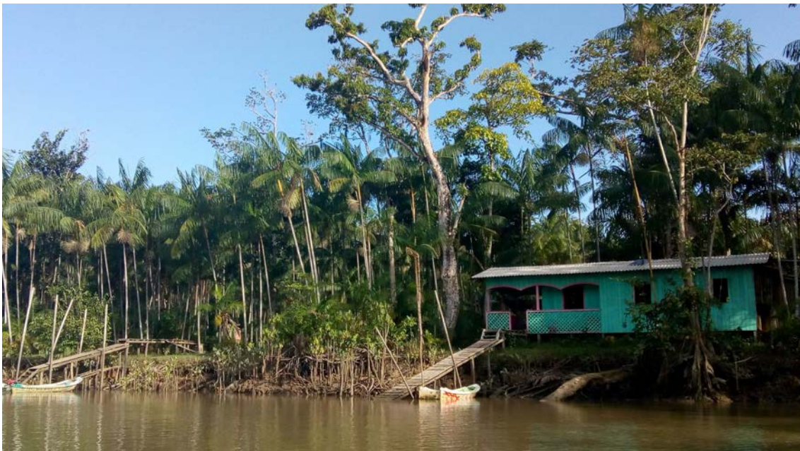
Figura 1. Ponte que liga o rio à moradia tradicional ribeirinha em Furo do Nazário, Barcarena, Pará (fonte: elaborada pelas autoras).
