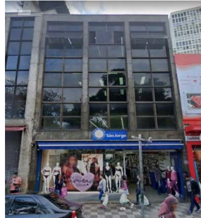
Figura 7. Imóvel na Rua 25 de Março. Fonte: Google Street View, imagem de junho de 2019.
