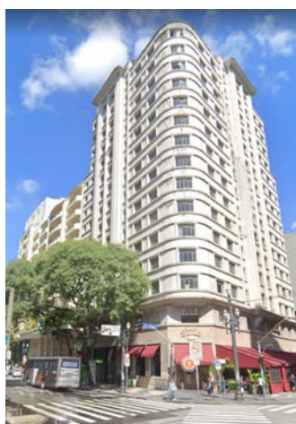
Figura 2. Edifício na Av. Ipiranga, 785. Fonte: Google Street View, imagem de março de 2020
