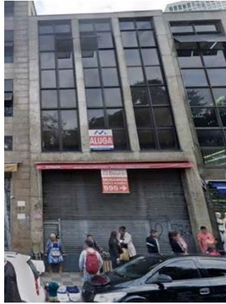
Figura 6. Imóvel na Rua 25 de Março. Fonte: Google Street View, imagem de junho de 2019.
