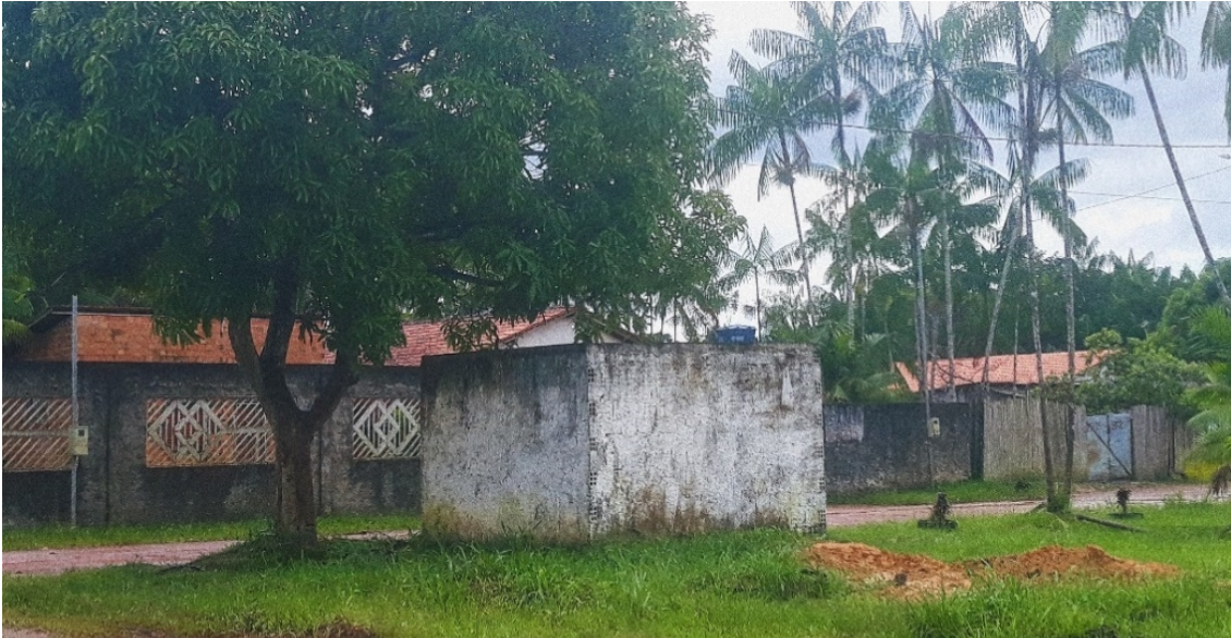
Figura 5. Nossa Senhora do Carmo. Poço do projeto de abastecimento de água (fonte: a autora, 2021)
