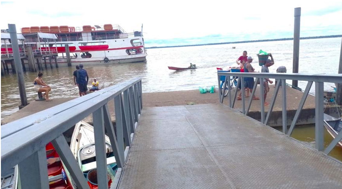
Figura 4. Porto do Açaí, Belém: rampa metálica e flutuante sem elementos que garantam segurança e conforto para grande maioria das pessoas (fonte: autora, 2023).
