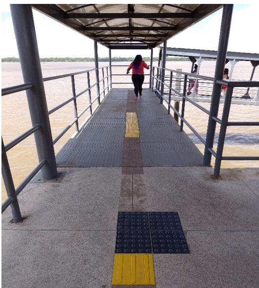
Figura 6. Belém, Pará: Terminal Hidroviário Ruy Barata. Pisos táteis aplicados de forma inadequada podem comprometer a orientação segura de pessoas com deficiência visual (fonte: autora, 2022).
