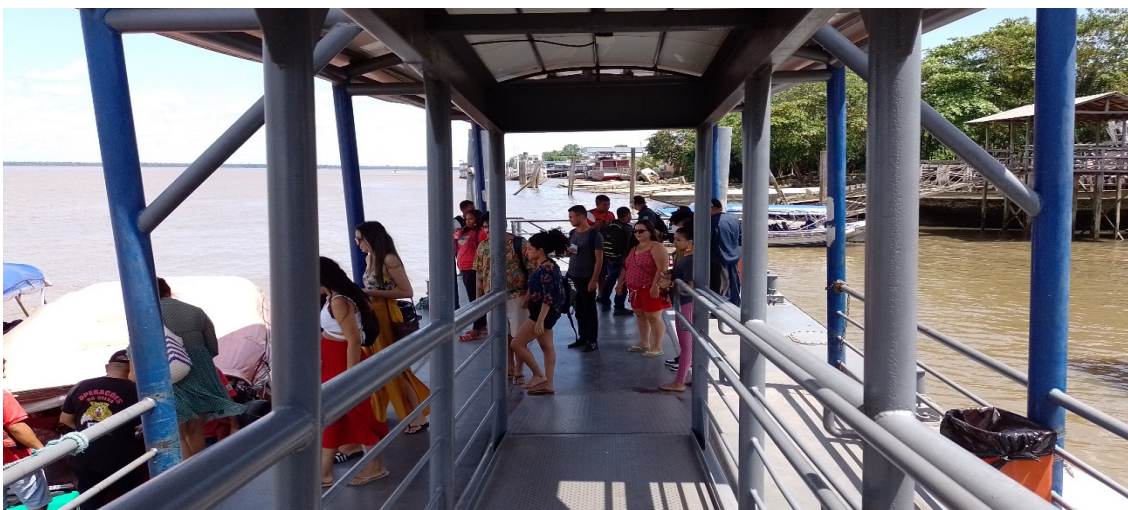
Figura 7. Belém, Pará: Terminal Hidroviário Ruy Barata. A instalação mínima de elementos de acessibilidade, a exemplo de pisos táteis para indicar desníveis, área de embarque e desembarque, além da instalação do corrimão apenas em um lado da rampa. (fonte: autora, 2022).
