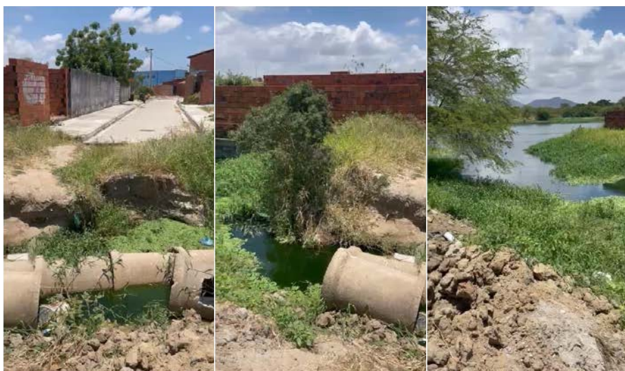
Figura 7. Trechos de registros em vídeo da infraestrutura abandonada no Marrocos próximo a Lagoa do Marrocos (fonte: acervo pessoal, 2022).
