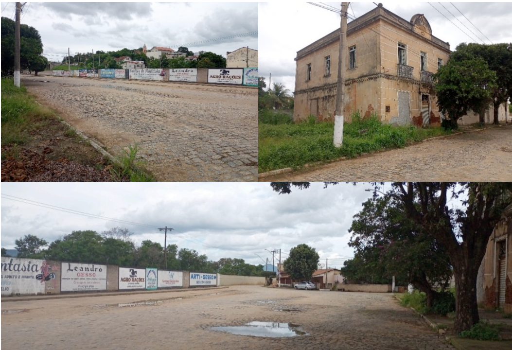
Figura 12. Excesso de pavimentação e situação atual do casarão (fonte: elaborada pelos autores).
