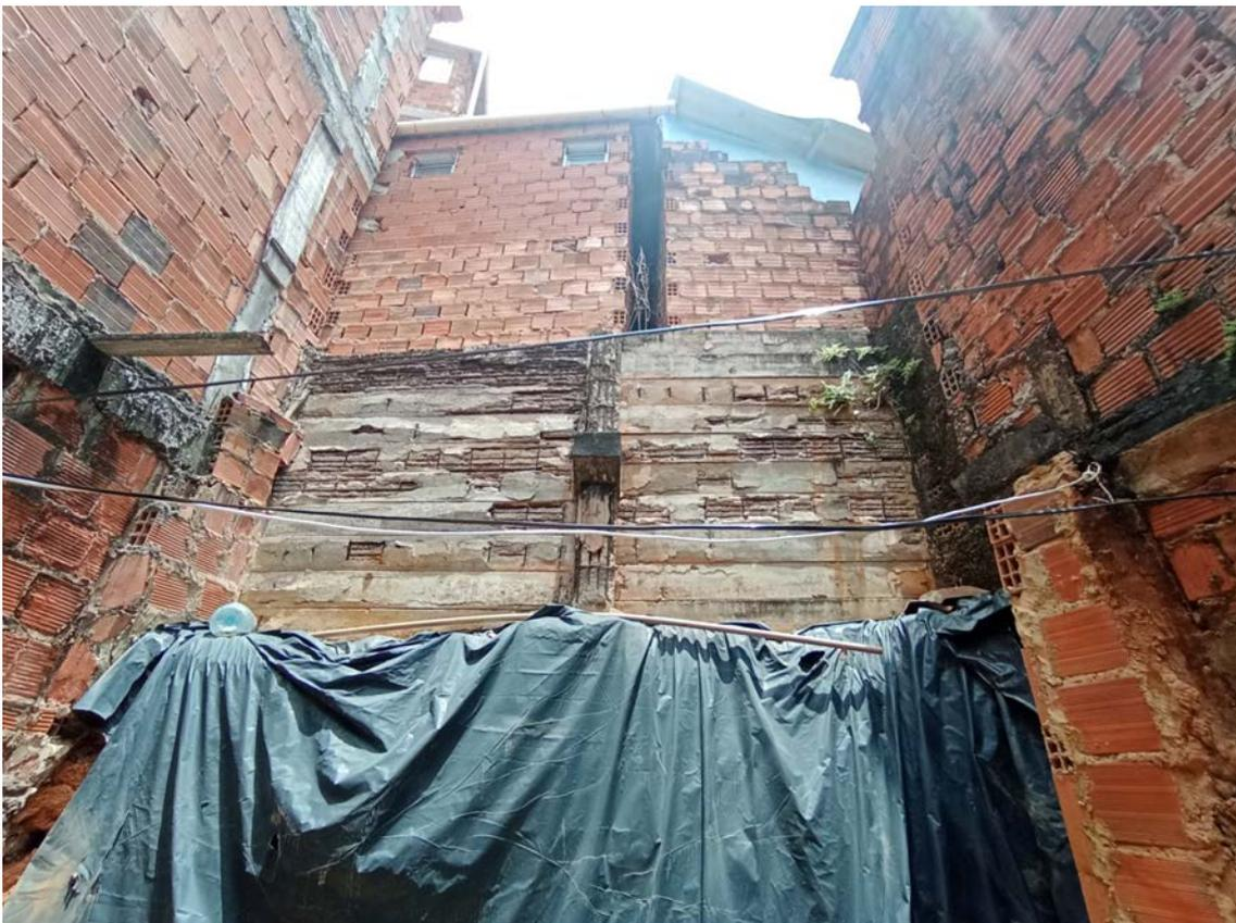
**Figura 2.** Trecho da contenção da encosta da Nova República, com sinais do deslocamento e exposição da estrutura, em outubro de 2022. (fonte: Coletivo Escalar, 2022.)
