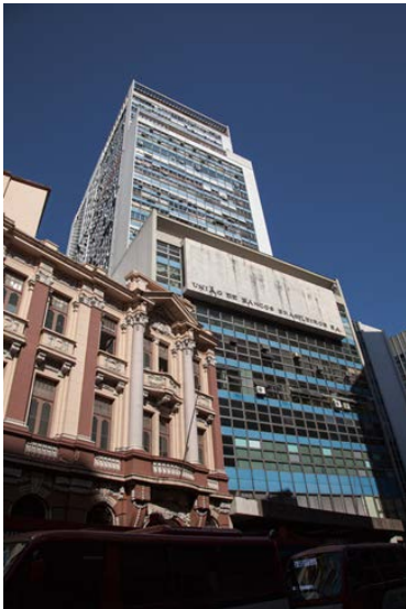
Figura 3. Edifício Santa Cruz em Porto Alegre (fonte: DONADUSSI, 2016).
