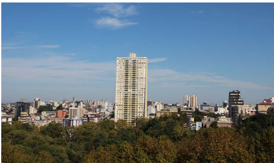
Figura 6. Edifício Parque do Sol, em Caxias do Sul, o mais alto do Rio Grande do Sul atualmente. (fonte: autores, 2019).
