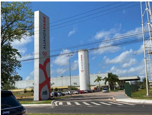
Figura 4. Prédio da Alianza Park, galpões de armazenamento e logística, localizado na BR-316, Benevides, PA (Fonte: próprio autor, 2022).
