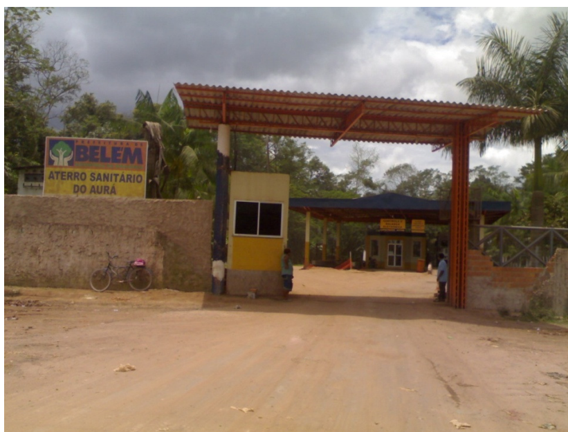
Figura 2: Acesso ao Aterro Sanitário do Aurá
