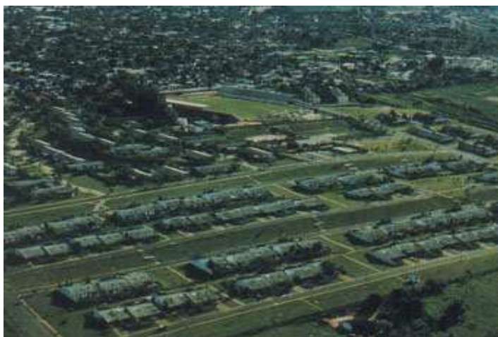
Figura 3. Casas em Fernandópolis, da UHE de Água Vermelha. Fonte: TSUKUMO, 1994, p105.
