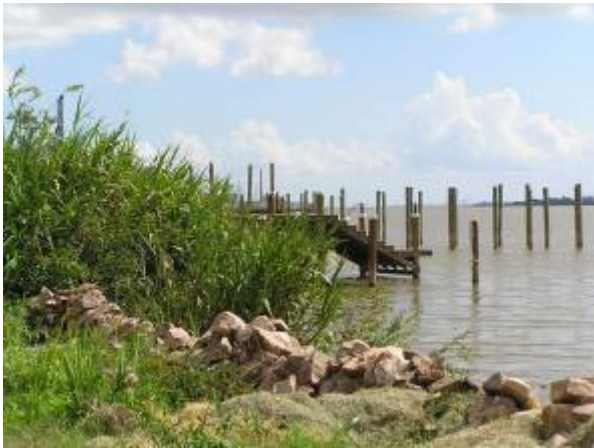
Figura 13: Construção de piers . Data: Junho de 2007. Fonte: Ecléa Morais.
