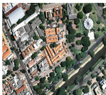
Figura 2: Vila Planetário depois da intervenção fonte: Google Earth
