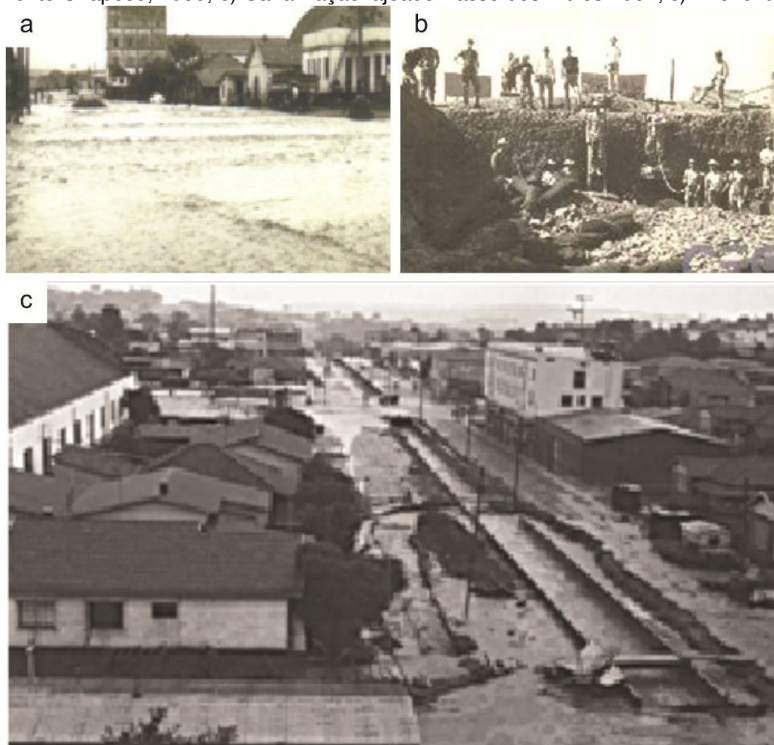
Figura 4: a) Enchente Chapecó, 1960; b) Canalização lajeado Passo dos Índios 1967; c) Enchente Chapecó, 1975.
