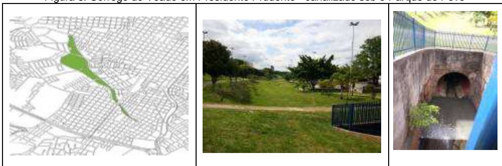
Figura 6: Córrego do Veado em Presidente Prudente - canalizado sob o Parque do Povo
