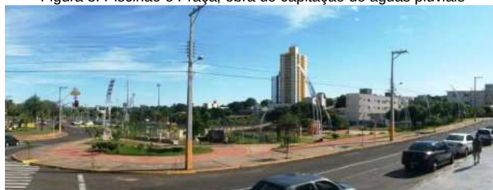
Figura 8: Piscinão e Praça, obra de captação de águas pluviais
